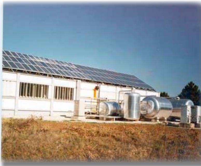
Prime installazioni di pannelli solari su edificio dell'ufficio tecnico del Centro
