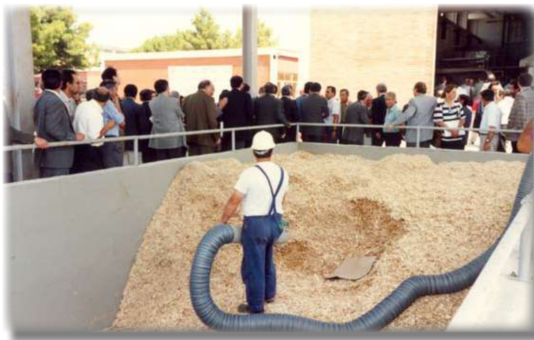
Vasca del cippato, impianto Steam Explosion
