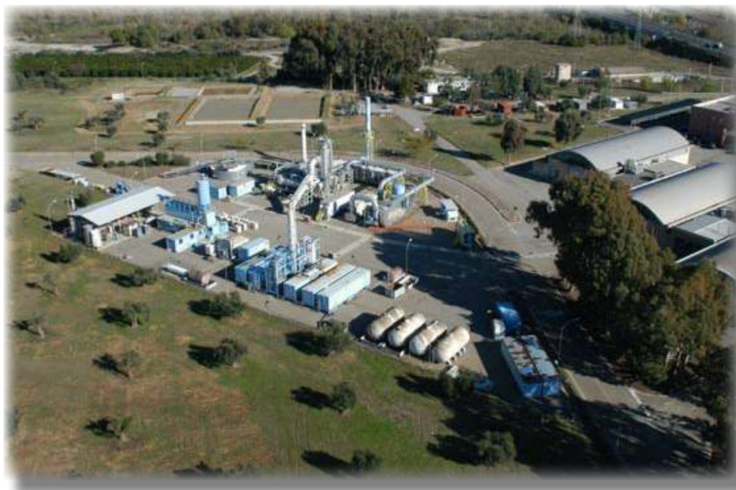
Veduta aerea degli impianti su scala pre-industriale per il trattamento rifiuti
