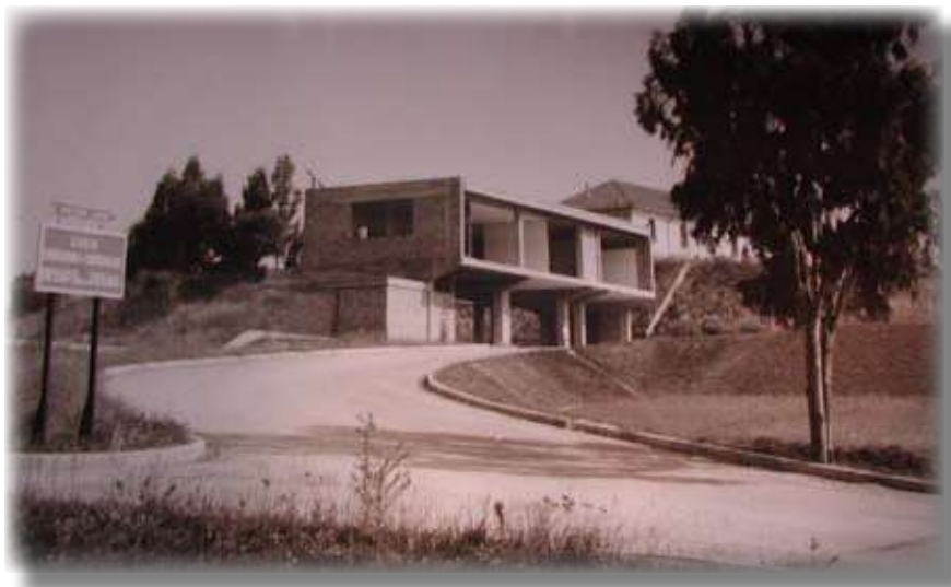
Lavori di costruzione del Centro Trisaia nel 1963 - particolare dell'ingresso
