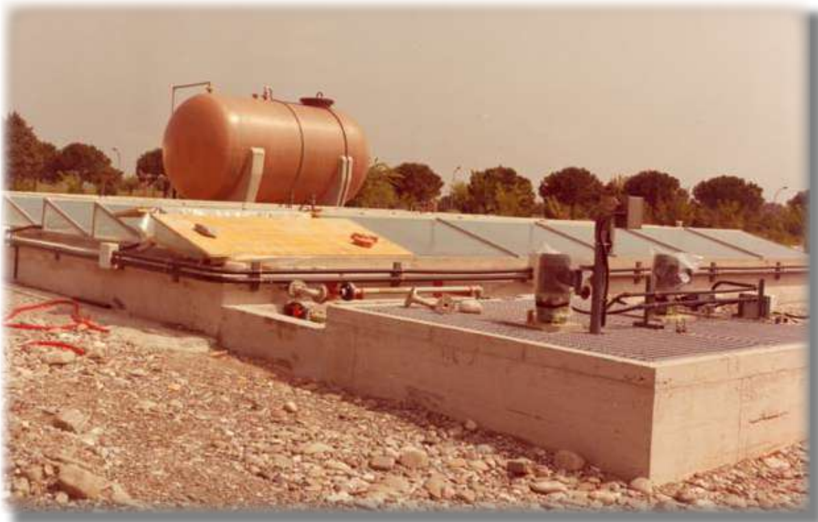
Impianto STILL, distillatore solare a vasca - primi impianti dimostrativi sulle fonti di energia rinnovabile
