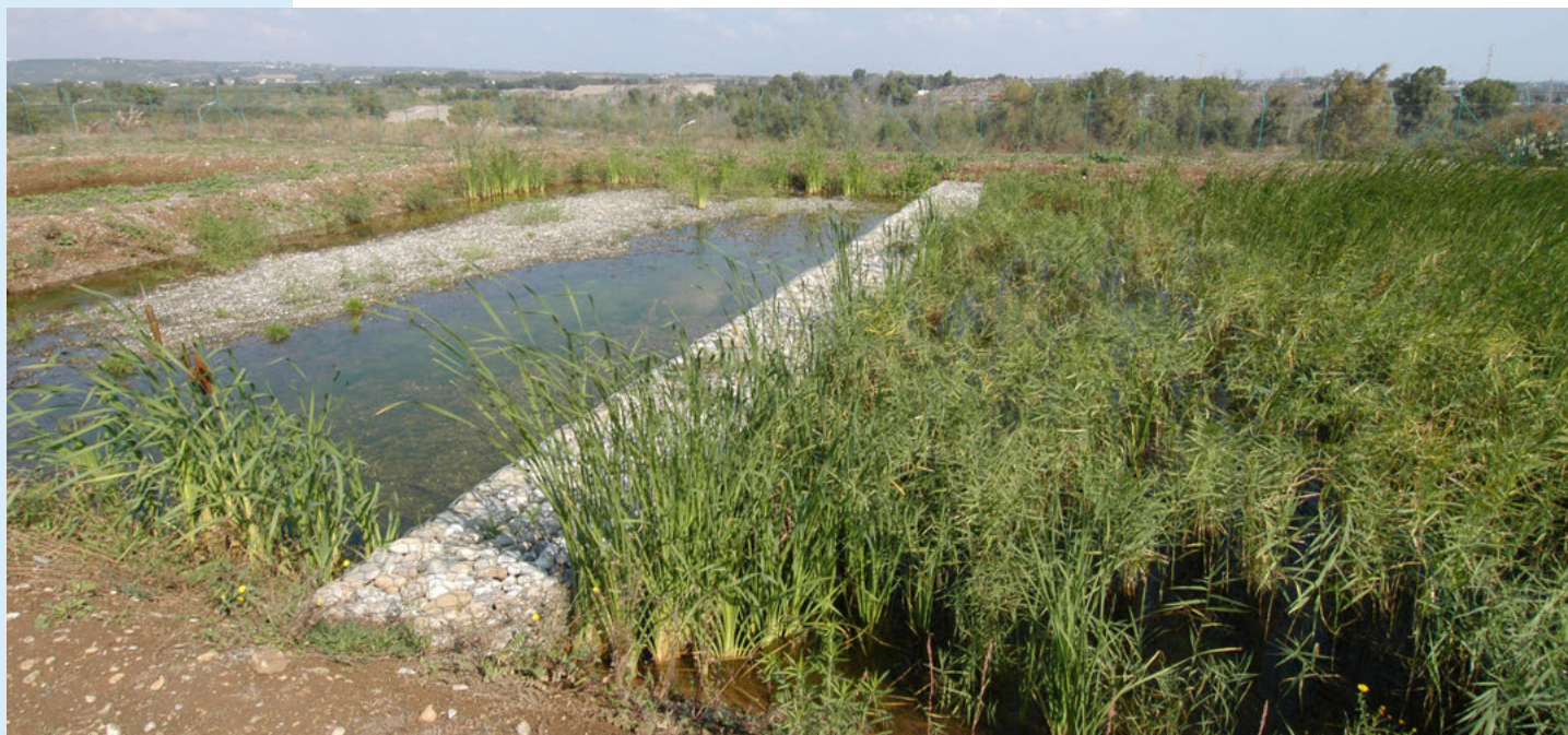
Figura 18: il Fitodepuratore
