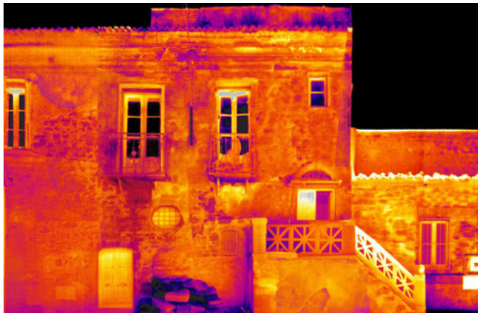
Figura 26: Analisi non distruttive di materiali edilizi: Elaborazione di immagini termografiche eseguite su Palazzo Agresta-D'Alessandro (Rotondella-MT).
